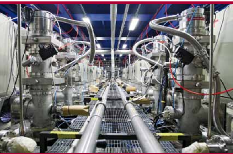
Fig.4.8: Il sistema di criogenia dell'esperimento ICARUS per la rivelazione dei neutrini ai Laboratori Nazionali del Gran Sasso.
