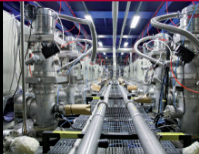
Fig.4.8: Il sistema di criogenia dell'esperimento ICARUS per la rivelazione dei neutrini, ai Laboratori del Gran Sasso.
