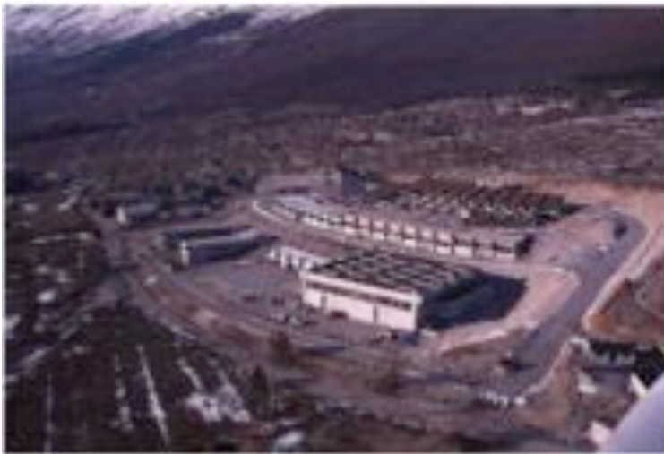
Fig.4.7: Veduta dei Laboratori esterni del Gran Sasso.
