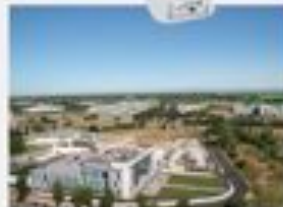
Fig. 3.31 Vista aerea del centro CNAO a Pavia.
